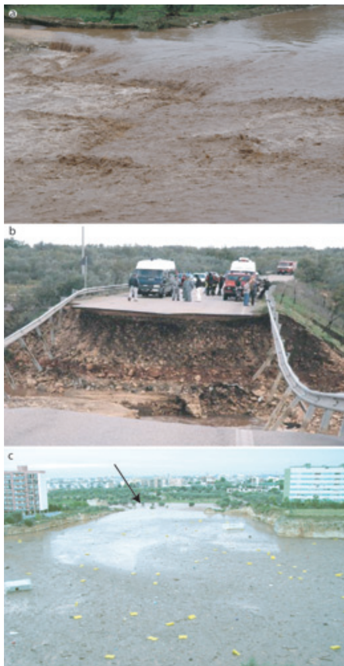
Figura 1. – a: Il T. Picone durante la piena del 22-23 ottobre 2005. Si noti l'energia del flusso ed il colore delle acque che denota un grande trasporto solido. b: il cedimento del terrapieno della SP 184. Ha provocato 5 delle 6 vittime dell'alluvione del 22-23 ottobre 2005. c: area ex-cava Di Maso. Un affluente del T. Picone (La Lama Baronale, visibile sullo sfondo, indicata dalla freccia) ha invaso la depressione della cava (che ha agito da "cassa di espansione" per la piena) colmandola di sedimenti fini trasportati e di materiali di un terrapieno adiacente alla lama stessa.
