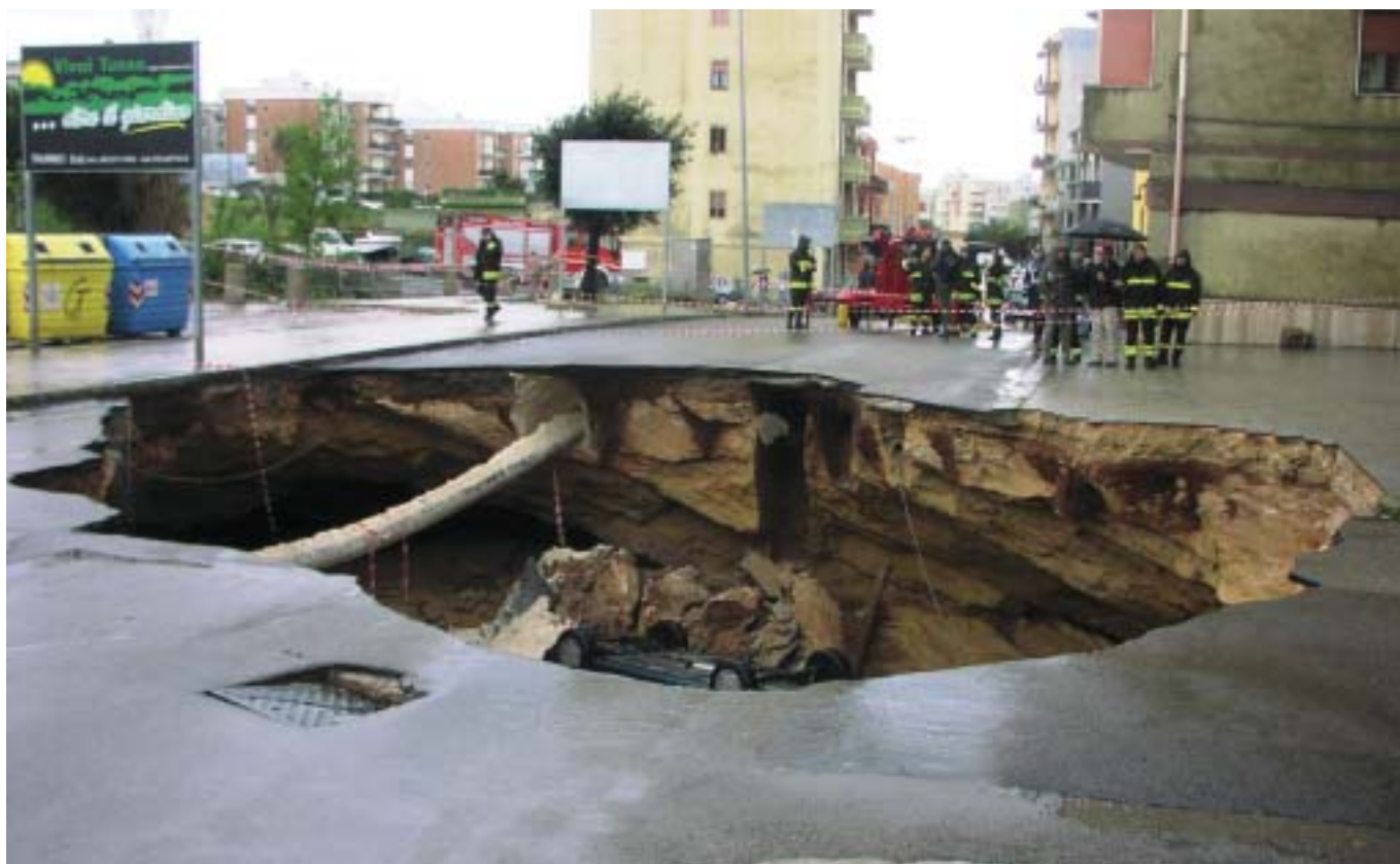
Foto 2 – La voragine come si presentava la mattina del 30 marzo. Si possono osservare la clinostratificazione degli strati, un tratto del bordo dello sprofondamento impostato secondo un sistema di fratture, una profonda trincea di scavo e una delle autovetture ingoiate nel dissesto
