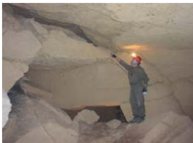
Foto 6 – Sopralluogo del 12 maggio 2007; ispezione del dissesto degli ipogei in prossimità degli edifici evacuati
