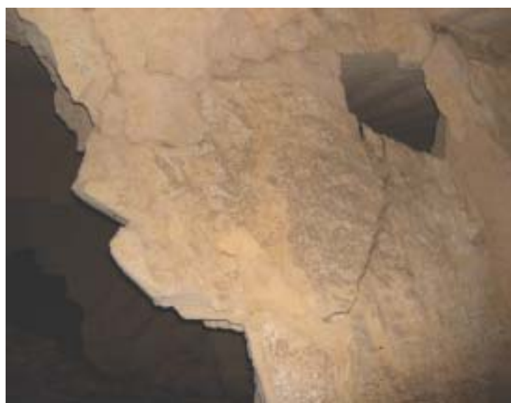
Foto 3 e 4 - Pilastri fratturati con evidenti segnali di sofferenza
