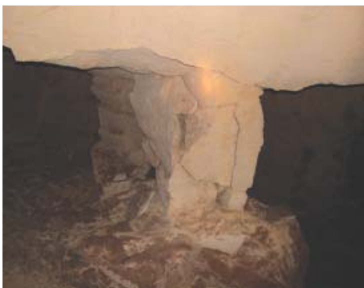
Foto 3 e 4 - Pilastri fratturati con evidenti segnali di sofferenza
