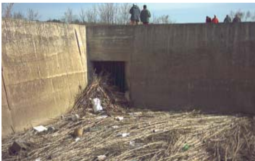
Figura 4 - Il principale inghiottitoio del sistema carsico Vore Spedicaturo posto sul lato della vasca di decantazione
