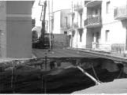
Il cantiere di viale... le palazzine sgombrate...
