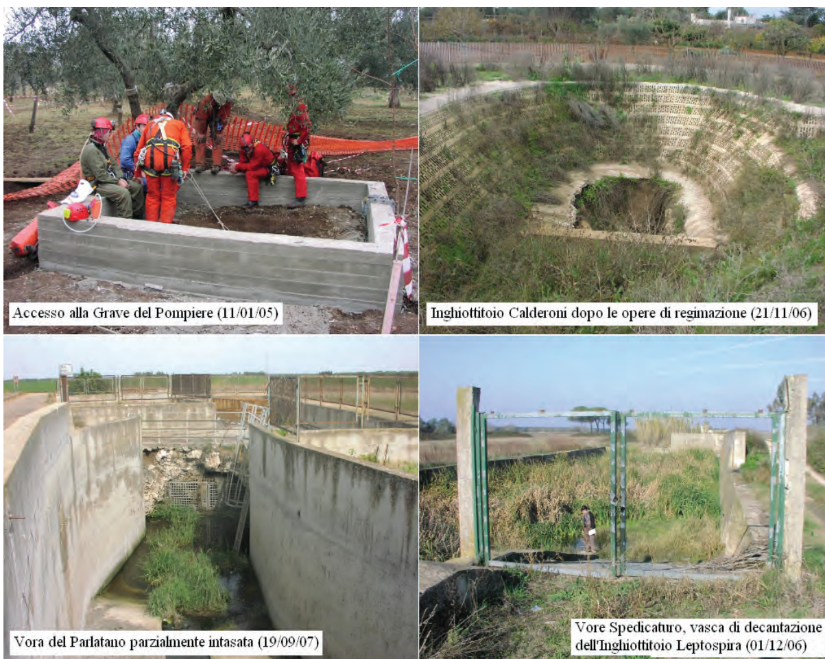
Figura 4 - Accessi degli inghiottitoi e tratti terminali dei sistemi fluvio-carsici
