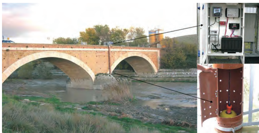
Figura 7 - Stazione di misura del trasporto solido in sospensione realizzata sul torrente Carapelle e particolari della strumentazione adottata
