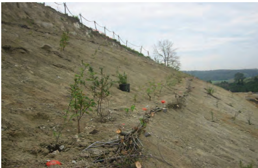
Foto 4 - Fascinata viva di tamerici e messa a dimora di arbusti mediterranei su scarpata in trincea - Fregene (RM)
