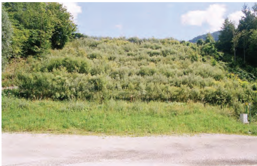
Foto 3 - Gradonate vive, canaletta con graticciata – Metanodotto Malborghetto–Bordano (UD), 2006
