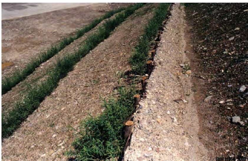
Foto 2 - Particolare gradonate vive, canaletta con graticciata - Metanodotto Malborghetto-Bordano (UD), 2002
