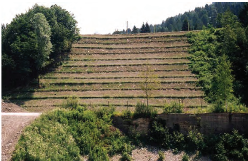
Foto 1 - Gradonate vive, canaletta con graticciata - Metanodotto Malborghetto-Bordano (UD), 2002
