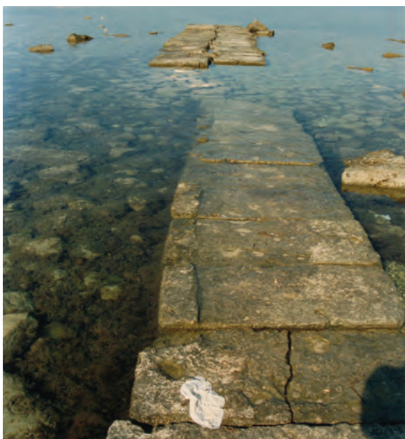
Figura 6 - Struttura greca (≈ 500 aC) parzialmente sommersa. Si ritiene essere parte di una struttura portuale. Presso Torre Ovo (Ta) (da Spilotro, 2003)
