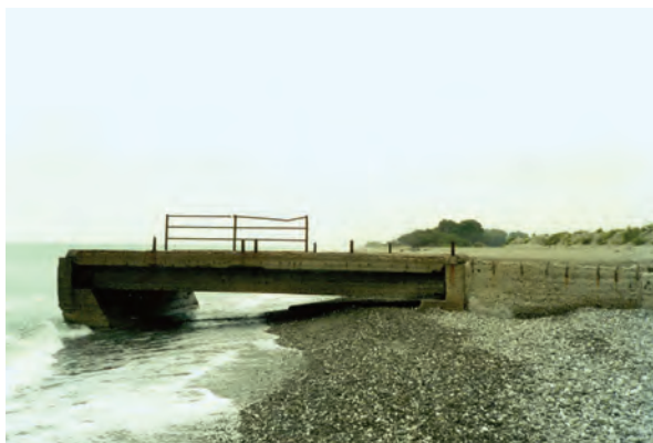
Figura 14 - Effetto dell'erosione costiera alla foce del f. Sinni (costa ionica della Basilicata). Il ponticello ormai in mare permette alla strada che portava sulla riva a circa 150 m di scavalcare un canale di bonifica
