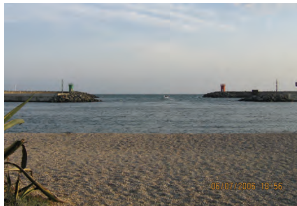
Figura 2 - Particolare del ripascimento in ghiaia
