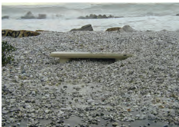
Figura 14 - Particolare della tracimazione della ghiaia
