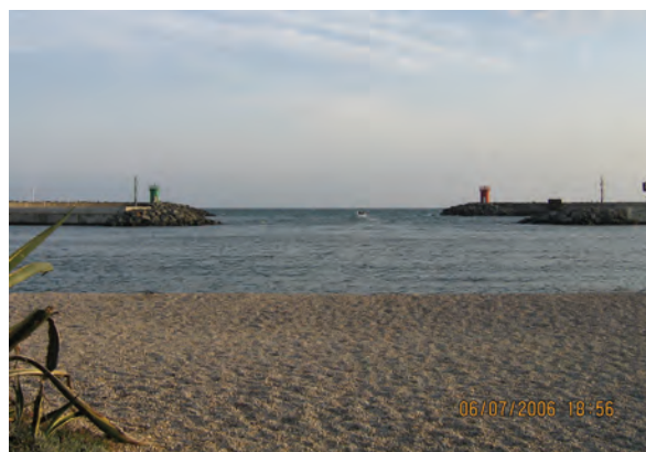
Figura 2 - Particolare del ripascimento in ghiaia
