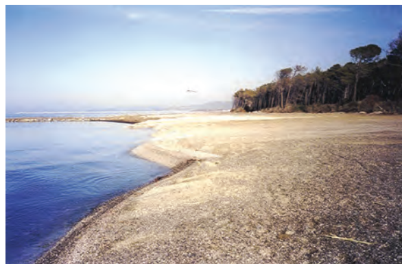
Figura 4 - Ripascimento in ghiaia in località Punta Tesorino
