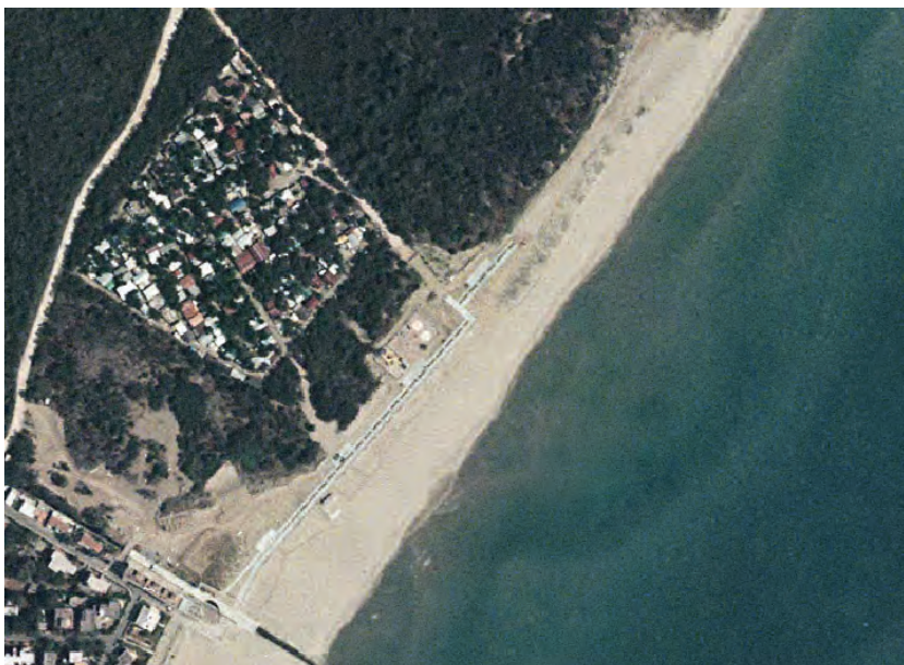
Figura 1 - Tratto del litorale metapontino interessato dagli interventi di stabilizzazione della costa
