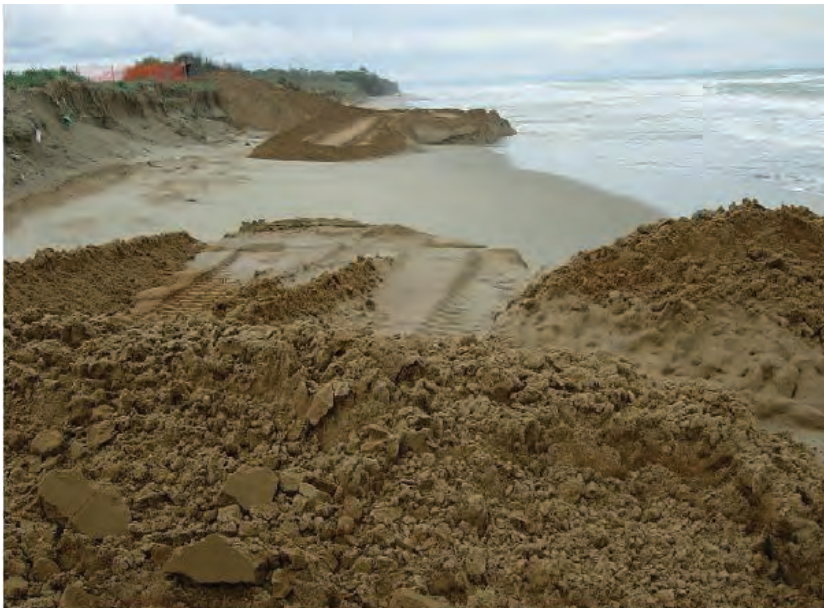
Figura 5 - Lavori di ripascimento a Metaponto
