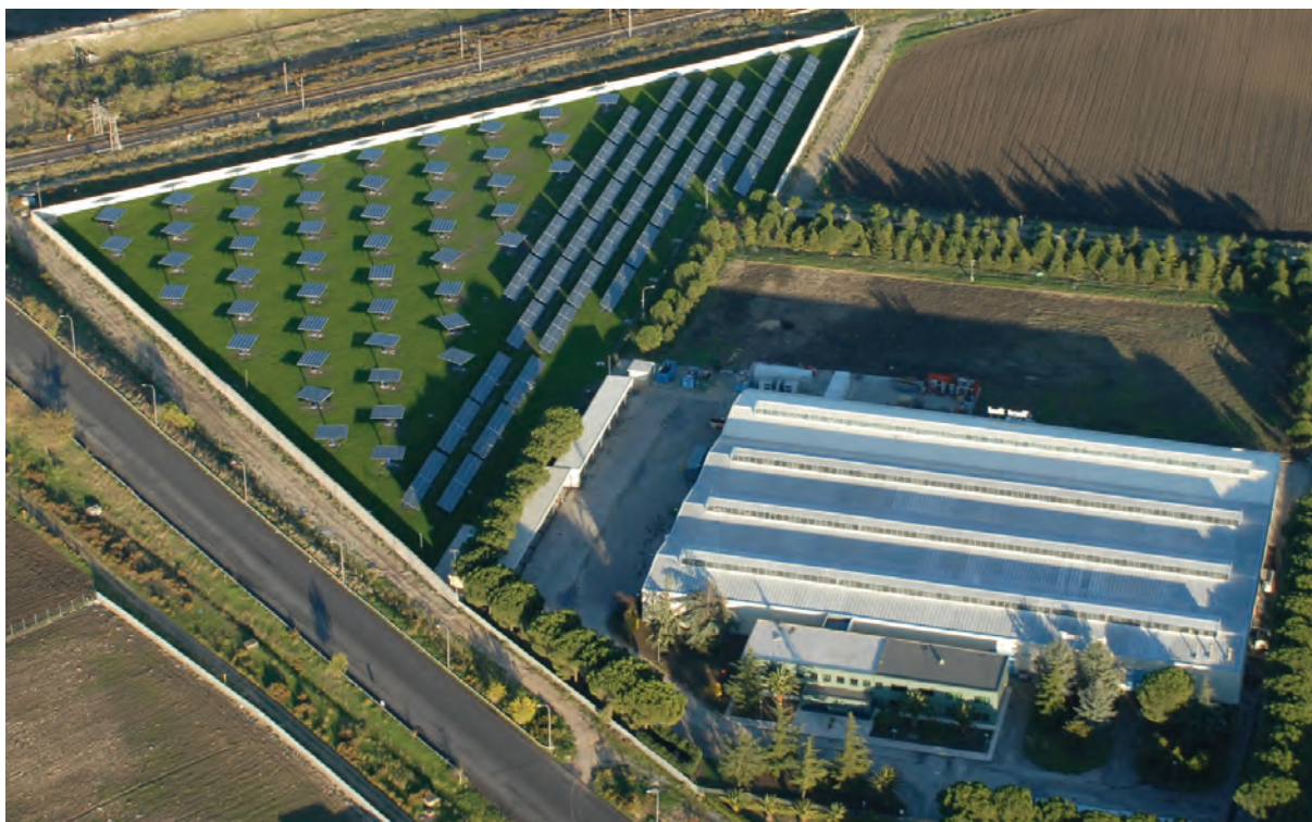
Figura 3 – Immagine dell'impianto fotovoltaico installato presso lo stabilimento della Tozzi Apparecchiature Elettriche a Foggia
