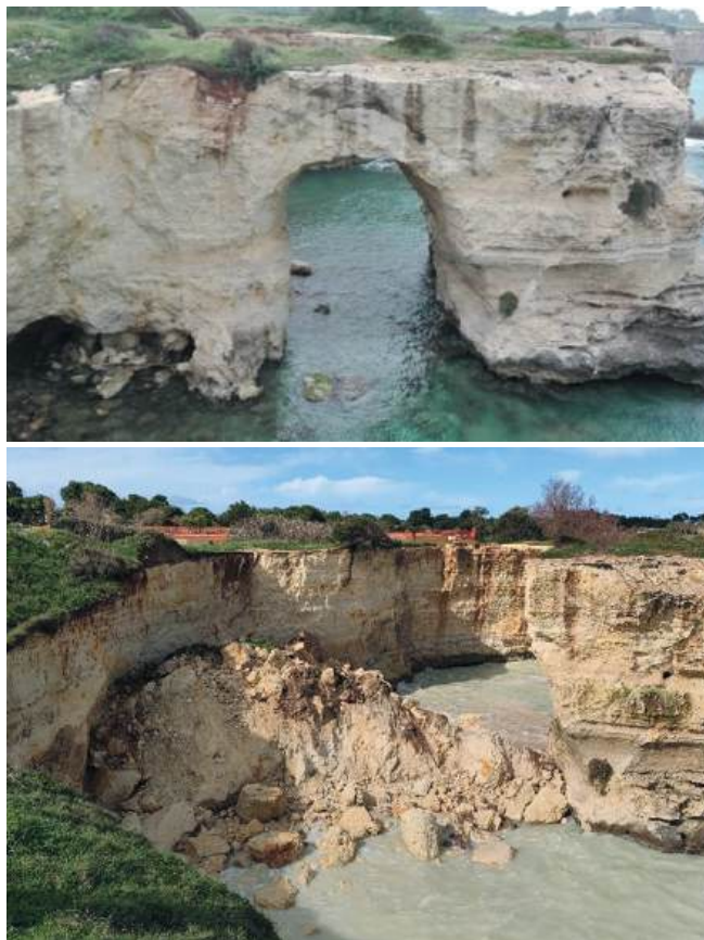
Figura 7 - Foto dell'arco di Sant'Andrea prima e dopo il crollo, avvenuto il 14 febbraio 2026.
