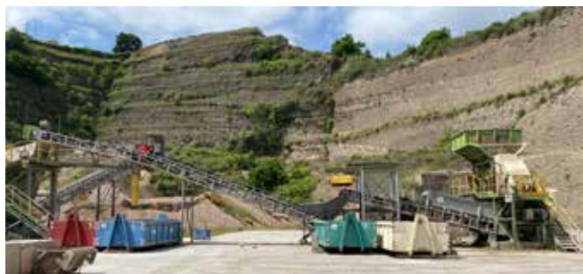
Figura 1 - Lavorazioni in un impianto di riciclo inerti.
