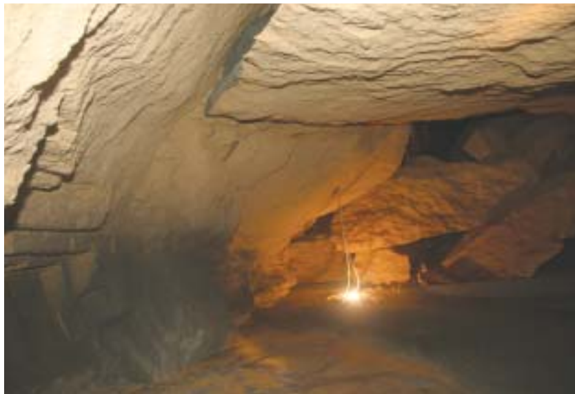
Foto 6 – Un grosso blocco ormai distaccato dall'ammasso roccioso che costituiva la volta ha raggiunto la sua condizione di equilibrio appoggiato su una parete
