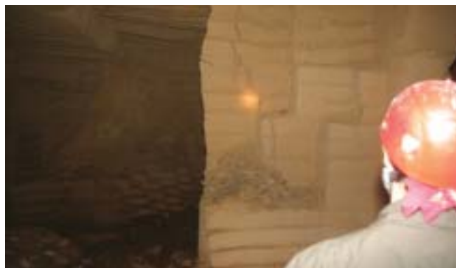
Foto 8 – Schiacciamento, fessure oblique, espulsione di materiale e distacchi interessano una colonna in un ampio ambiente adiacente alla cavità crollata
