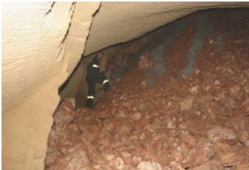
Foto 13 – La voragine è stata ricoperta. Il materiale di riempimento si è disposto secondo il proprio angolo di natural declivio
