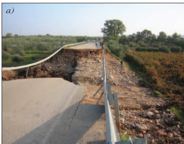
Fig. 10.1 a,b – L'onda di piena, in corrispondenza della SP Bitetto-Cassano, ha portato via il rilevato stradale
