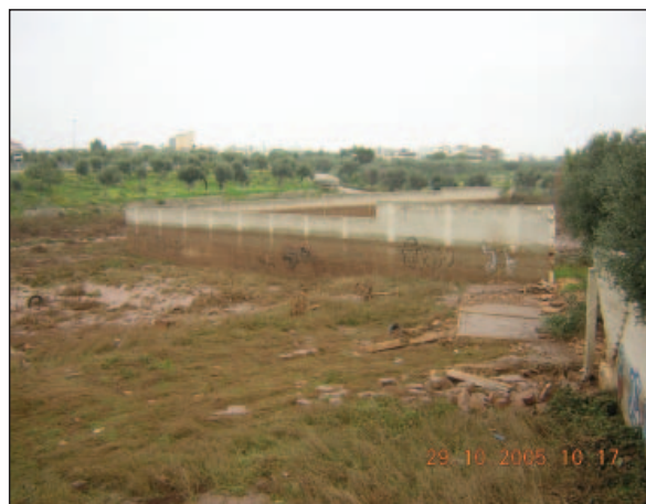
Foto 11.2 - Muro di recinzione che sbarrava l'alveo T. Badessa all'altezza di Carbonara
