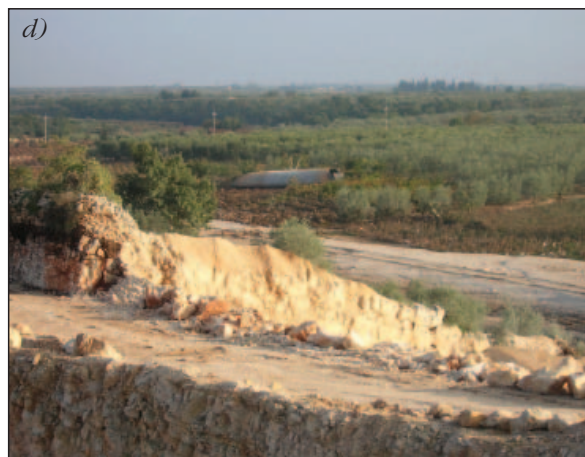
Fig. 10.1 c,d – A valle del rilevato stradale crollato, il deflusso di piena è stato sbarrato dal muro di recinzione di un impianto di lavorazione di inerti calcarei (c) estratti da una cava in fregio all'alveo del T. Badessa. Sullo sfondo è visibile il tubo “armaco” divelto e trasportato a notevole distanza dall'onda di piena
