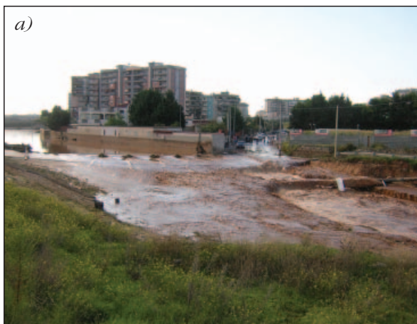
Foto 11.4 a, b - Passaggio dell'acqua, nella fase di esaurimento dell'onda di piena, in corrispondenza dell'attraversamento della strada di accesso al Quartiere S. Rita (a). Il rilevato stradale ha ostacolato il deflusso dell'acqua che, esondando, ha allagato una vasta zona a monte dello sbarramento e causato una parziale esondazione (b)
