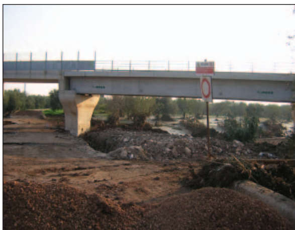
Foto 11.6 - Alveo del T. Badessa in corrispondenza dell'attraversamento della linea metropolitana all'altezza di Bitritto
