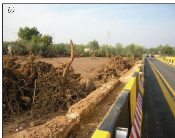
Foto 11.8 a, b - Tombinatura della Strada Provinciale Bitritto-Loseto parzialmente ostruita dal materiale solido trasportato dal T. Badessa (a). L'insufficienza delle opere idrauliche ha causato la tracimazione della sede stradale e lesioni alla struttura del ponte (b)
