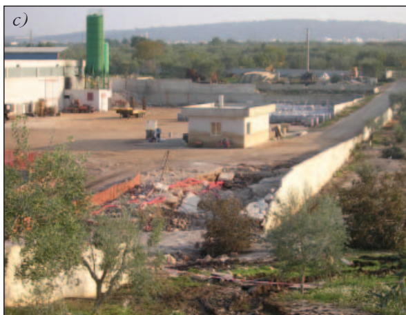
Fig. 10.1 c,d – A valle del rilevato stradale crollato, il deflusso di piena è stato sbarrato dal muro di recinzione di un impianto di lavorazione di inerti calcarei (c) estratti da una cava in fregio all'alveo del T. Badessa. Sullo sfondo è visibile il tubo “armaco” divelto e trasportato a notevole distanza dall'onda di piena
