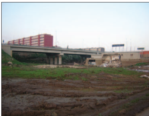
Foto 11.1 - Azienda avicola a monte del Viadotto S. Rita
