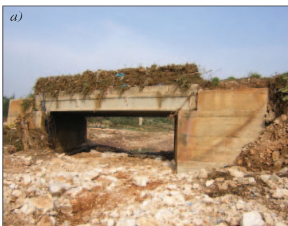
Foto 11.8 a, b - Tombinatura della Strada Provinciale Bitritto-Loseto parzialmente ostruita dal materiale solido trasportato dal T. Badessa (a). L'insufficienza delle opere idrauliche ha causato la tracimazione della sede stradale e lesioni alla struttura del ponte (b)
