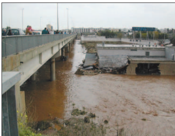
Fig. 10.4 - Crollo del fabbricato di un'azienda del viadotto S. Rita
