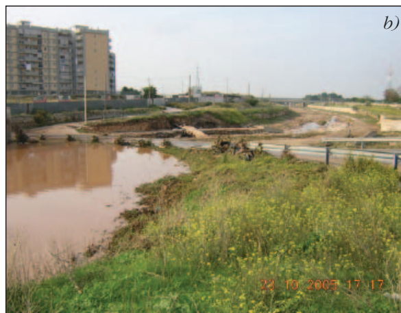
Foto 11.4 a, b - Passaggio dell'acqua, nella fase di esaurimento dell'onda di piena, in corrispondenza dell'attraversamento della strada di accesso al Quartiere S. Rita (a). Il rilevato stradale ha ostacolato il deflusso dell'acqua che, esondando, ha allagato una vasta zona a monte dello sbarramento e causato una parziale esondazione (b)
